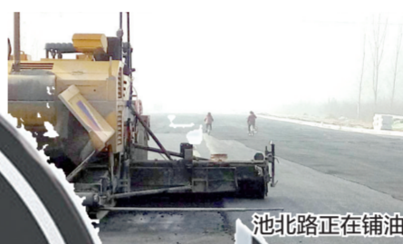
池北路正在铺油
