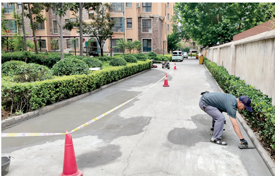
工作人员在修路
